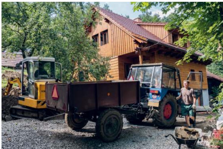
Die Zufahrt zum Haus des Gebets musste dringend saniert werden.
